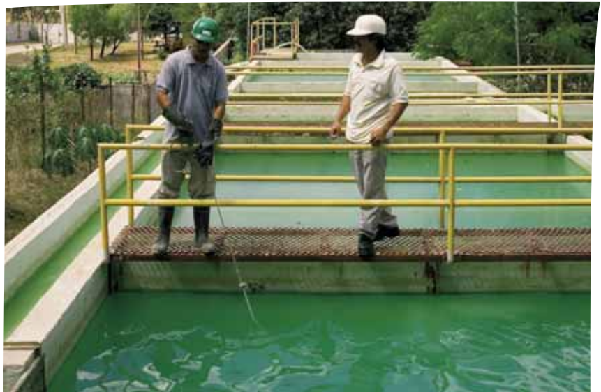
Jube Avelino R. Foronda en Alfonso Mauricio controleren de recuperatie van vaste stoffen in een decantatiebekken in Subic, Filippijnen.
